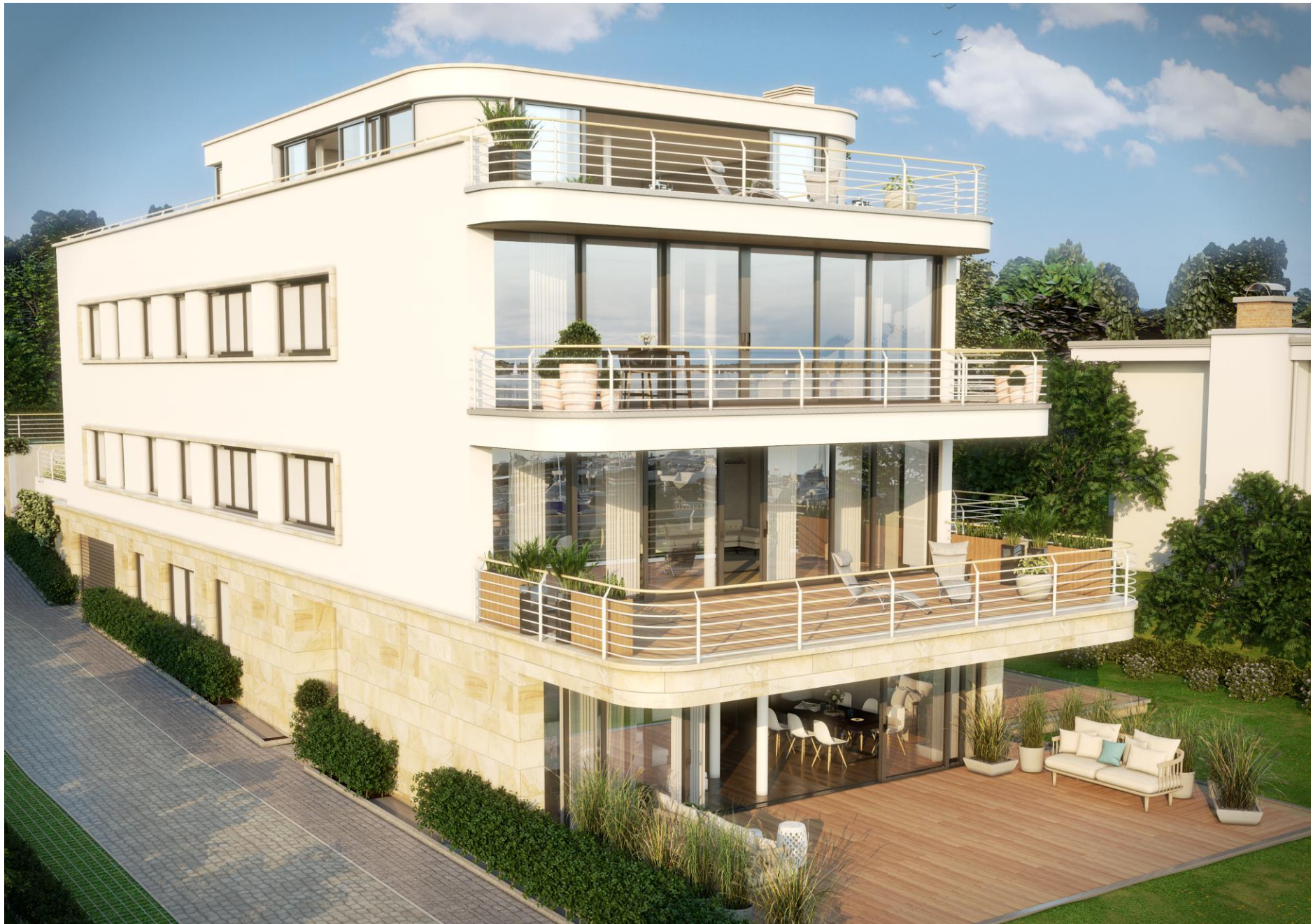
Wohnanlage Luxury Lakeside Living , Berlin-Wannsee, Am Großen Wannsee
